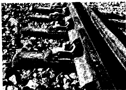
写真6 ポイント用レールプレス (横弾性支持)
