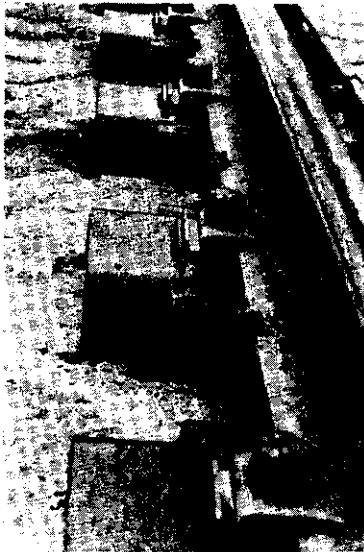
写真 13 無導床短鉄マクラギ受台式レール弾性締結装置 (アンチクリーパー付勾配50/1,000区間)
